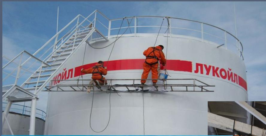
Рекомендуется применение в качестве защитных покрытий индустриальных конструкций, работающих в средах с высокой степенью агрессивности.
